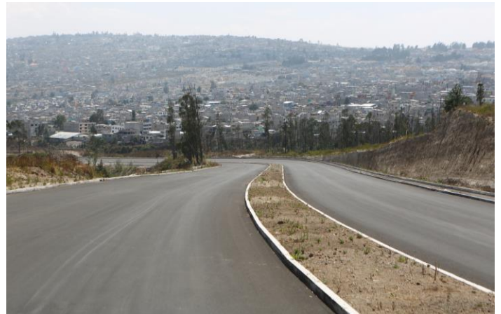
Foto: Prolongación de la Av. Simón Bolívar
