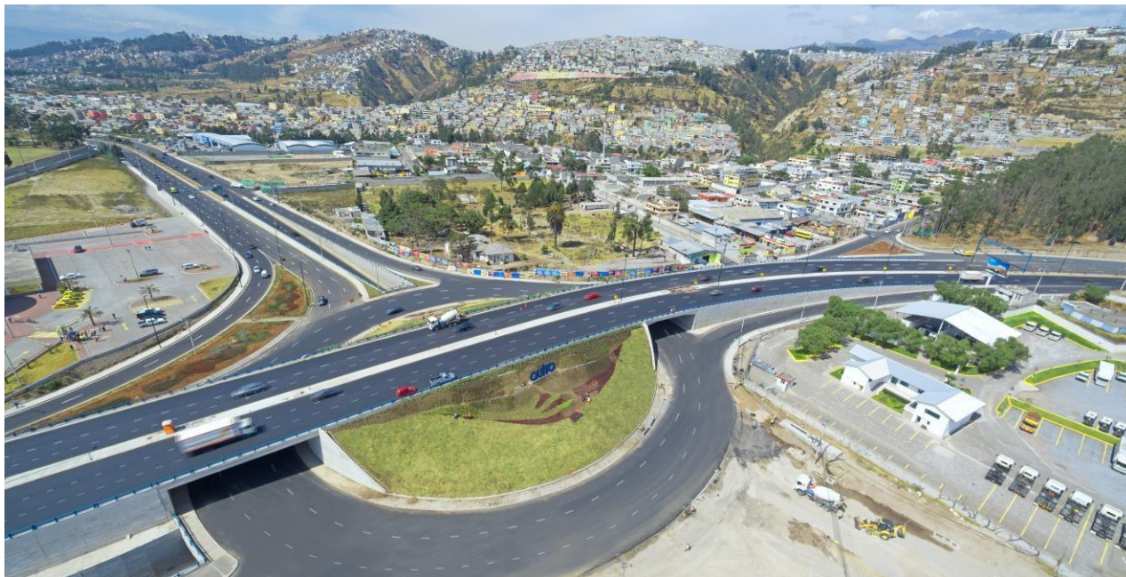
Foto: Intercambiador de Carapungo. Intersección Av. Panamericana Norte y Av. Simón Bolívar
