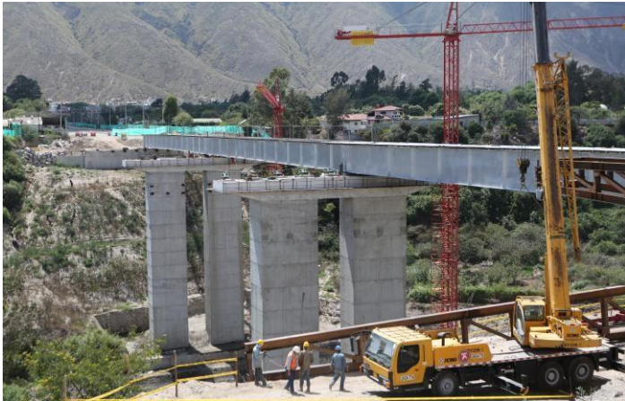
Foto: Construcción puente de Los Pájaros
